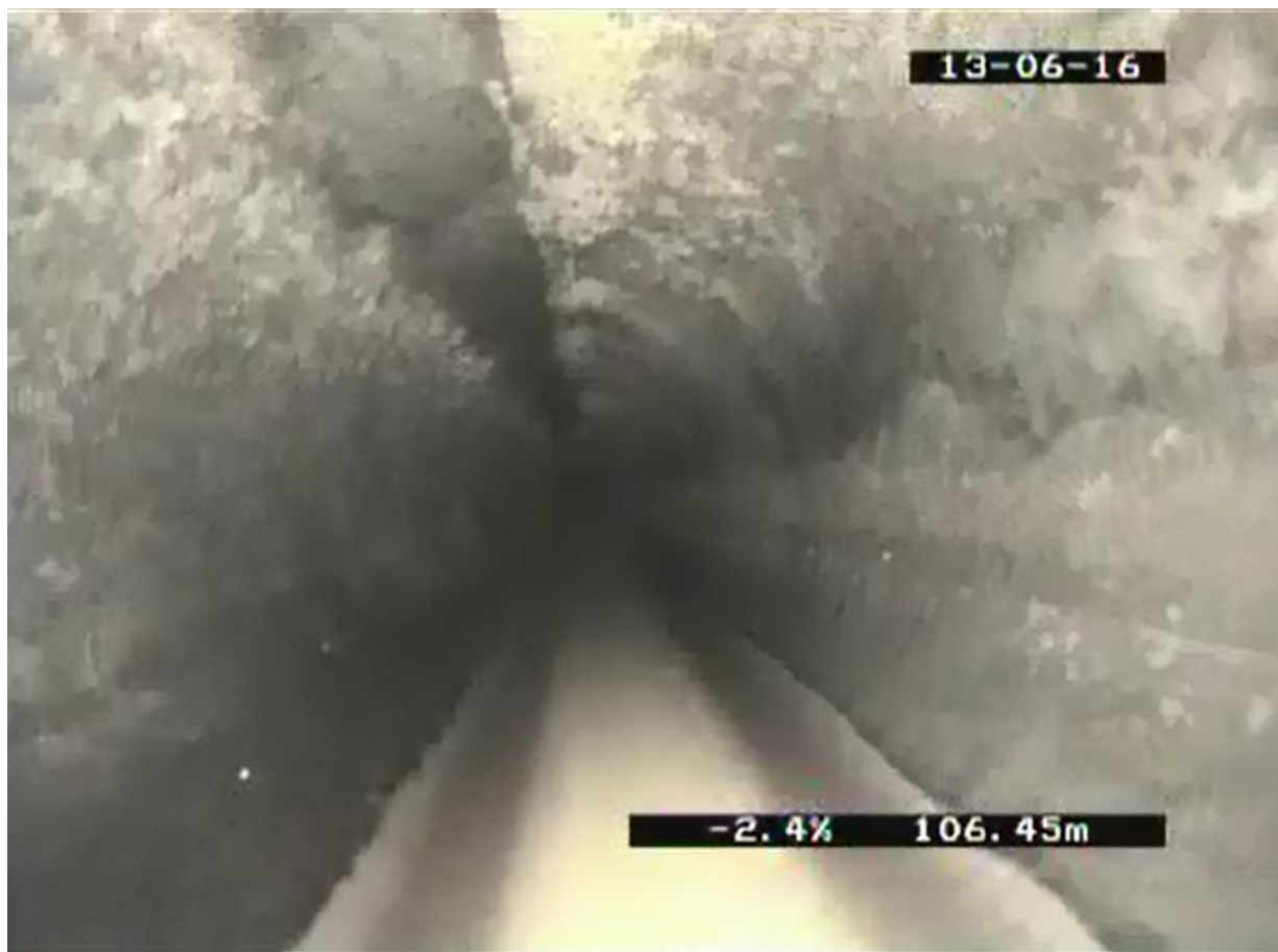
Vyčištěná část výtlačného potrubí
