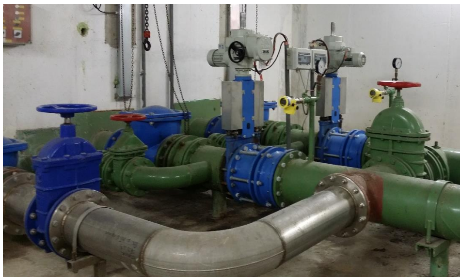
Zapojení tlakoměrů
