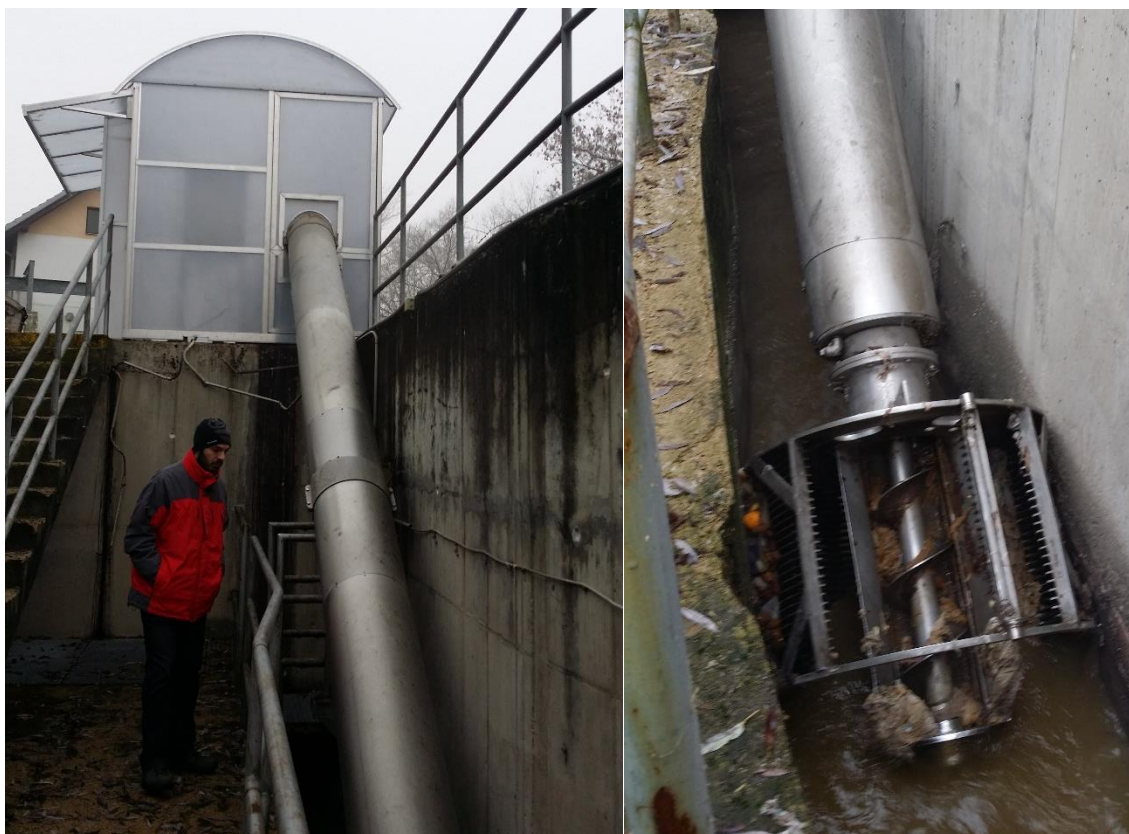
Hrubé přečištění a doprava shrabků
