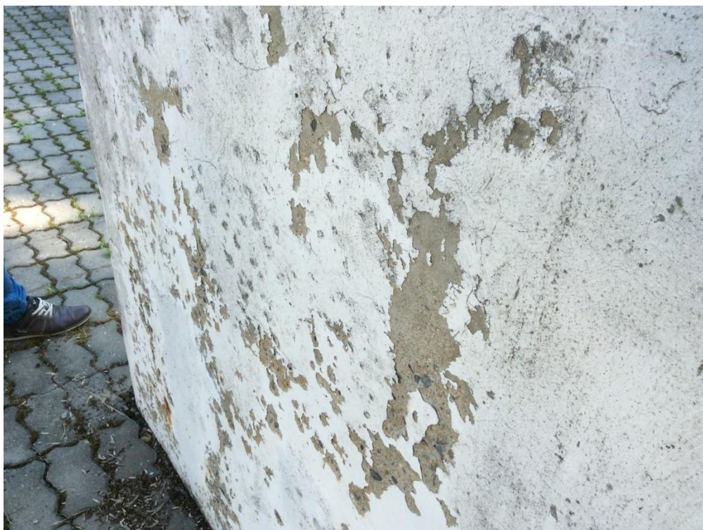
Poškozený povrch stěn
