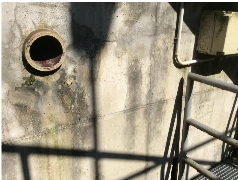
Poškození betonu kolem napojení kanalizace
