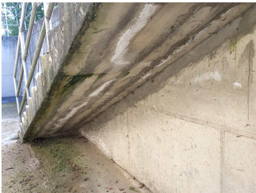
Poškození betonových konstrukcí schodiště
