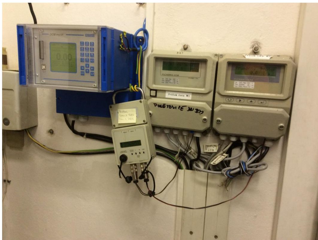
Dataloger pro sběr dat z indukčních průtokoměrů
