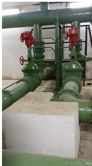
Schéma připojení protirázové ochrany a propojení obou větví
