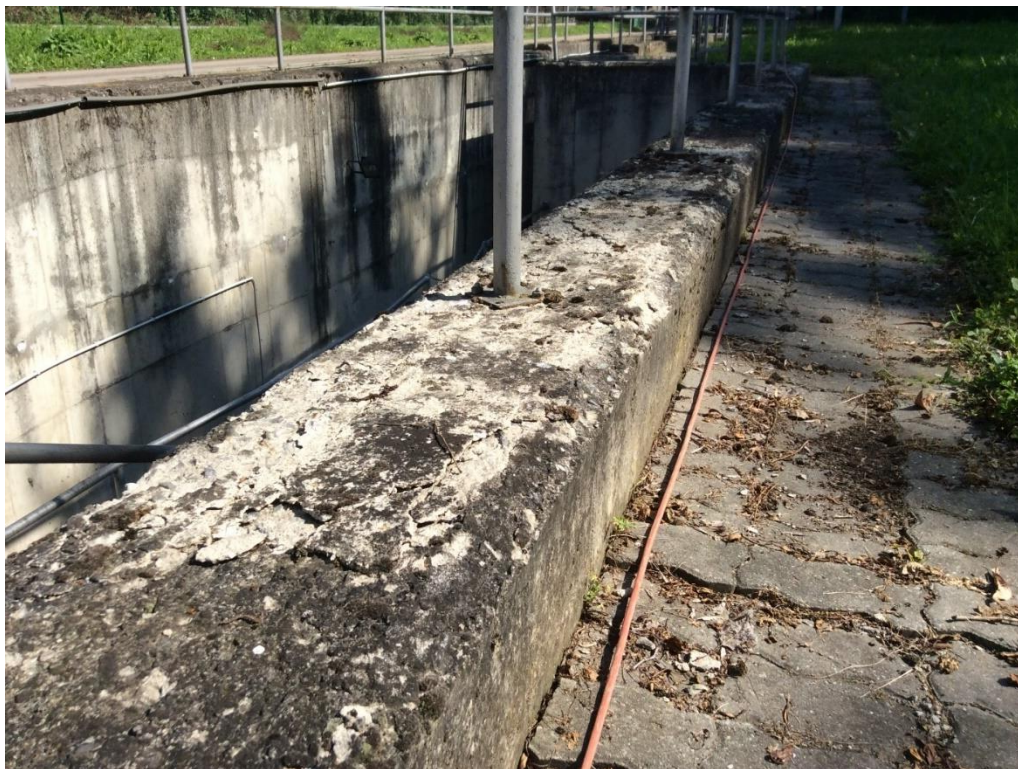
Poškození betonových konstrukcí
