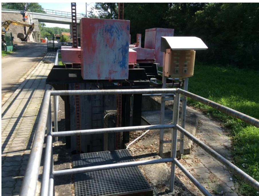
Ovládání stavidel v odlehčovací komoře
